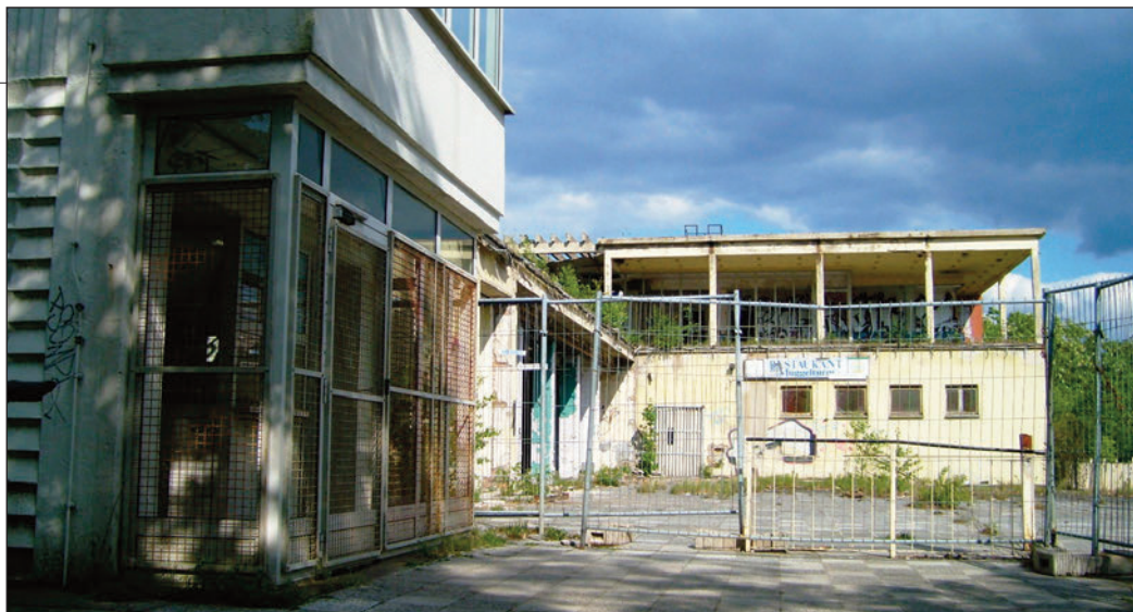
Geschlossenes Restaurant am Müggelturm vor der Sanierung 2013.
