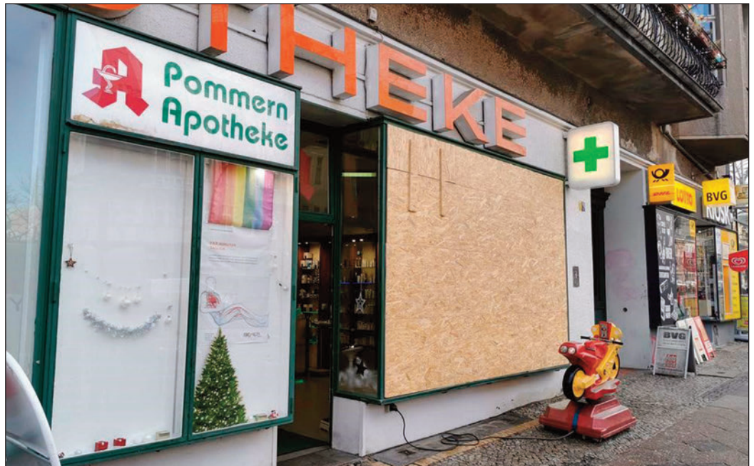
Die zersplitterte Scheibe dieser Apotheke in der Hauptstraße wurde mit einer Spanplatte provisorisch ersetzt.
